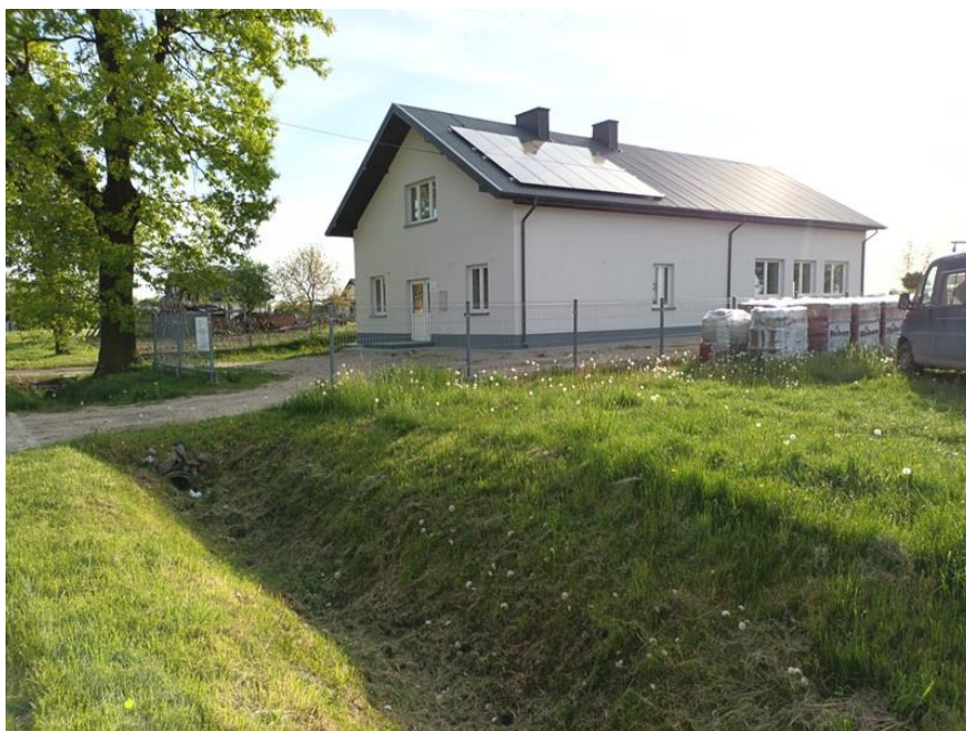
Opracowanie własne – świetlica w Kazimierzowie po pracach termomodernizacyjnych
